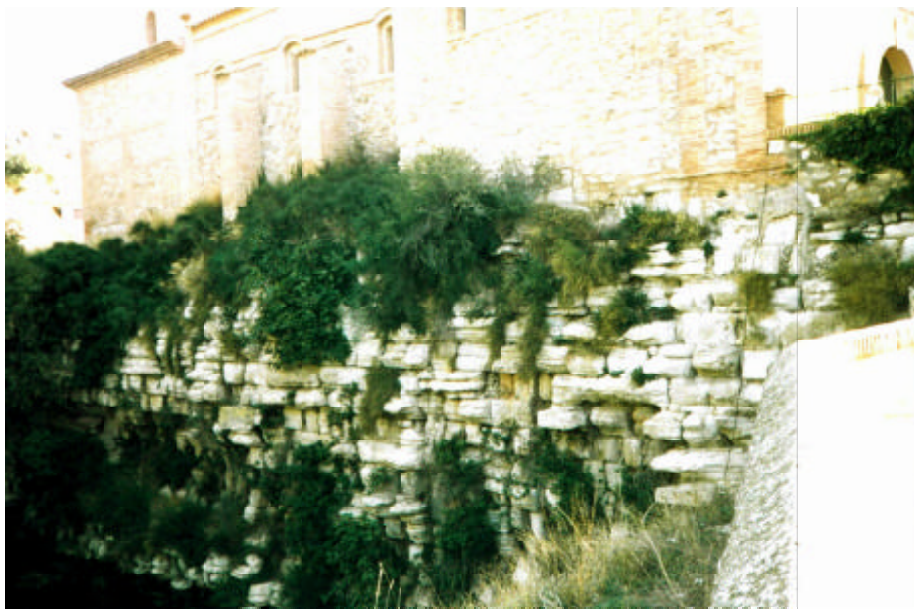
Presa de Muel. Muel (Zaragoza).
