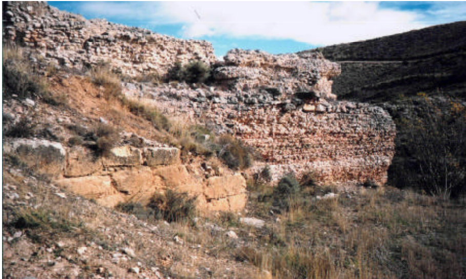
Presa de la Ermita de la Virgen del Pilar. Monforte de Moyela (Teruel).
